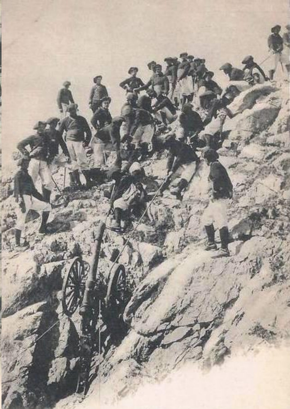
Batterie Alpine en manœuvre au Col de Fours (Ubaye)
